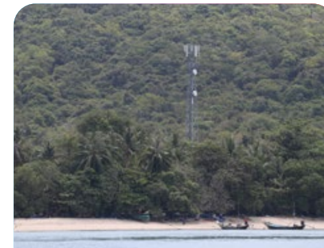
→ ดำเนินการติดตั้งเสาสัญญาณพลังงานแสงอาทิตย์ในพื้นที่เกาะนกเกาะ
